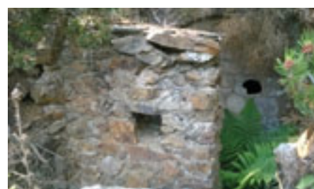
Búnquer de refugi del centre de resistència 47
