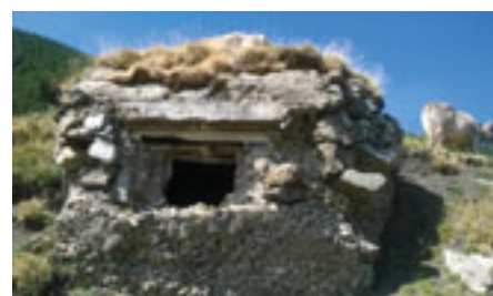
Búnquer de metralladora del centre de resistència 45 bis
